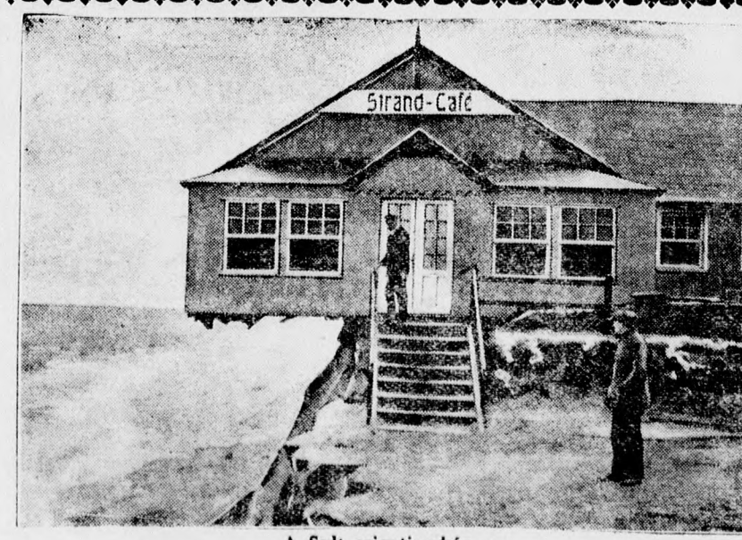
A Sylt szigeti orkán. A magasra szökő hullámok az egyik nyári kávéház alól a sziklát kimoszták, úgyhogy az épület felerészben a levegőben lóg.
