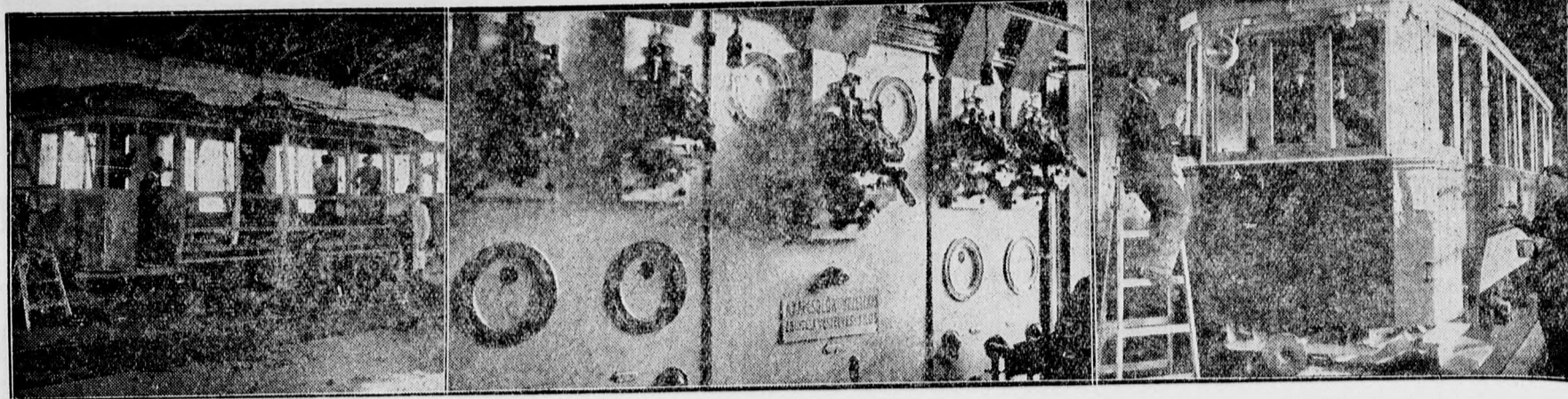
Balról jobbra: 1. Egy villamoskocsi javítás alatt. 2. A cikkben említett nagy kapesolótábla, amely az igazgatósági épületben van elhelyezve. 3. Fényezik a javítás alól kikerülő kocsit, amely kifogástalan állapotban kerül ki a HÉV. javítóműhelyéből. (Berzéki felvételei.)
