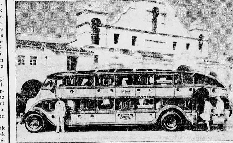
Óriási amerikai autobus, amely hosszabb utak megtételére a legteljesebb kényelemmel van berendezve. Éjjel az ülőhelyek hálólhelyekké alakíthatók. Az új autobus Kaliforniában Portland és San Diego között közlekedik.
