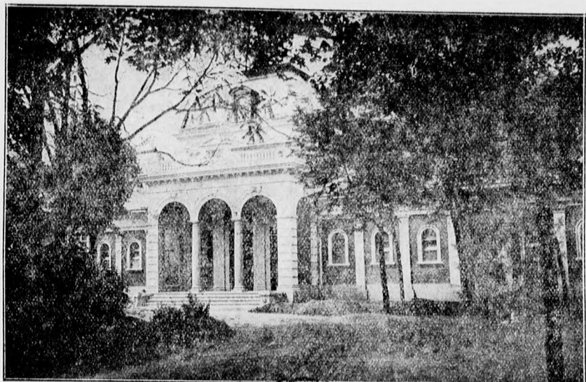
A Margit-fürdő főépületének homlokzata.
