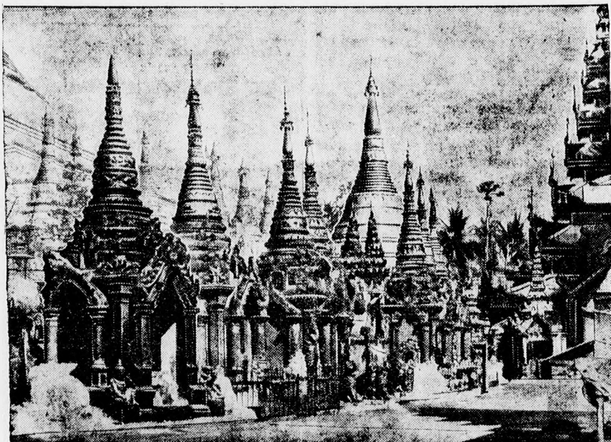
Földrengés Hátsó-Indiában. A világ legnagyobb templom építményének, a nagy Sve-Dagon pagodának előcsarnokai, amelyeket súlyosan megrongált a földrengés, amelynek hatezer ember esett áldozatul.
