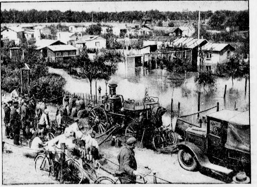
Gőzszivattyúkkal távolítják el Berlin egyik előtörtött városrészéből a vizet.
