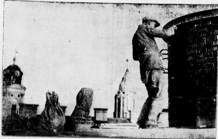
Munka magasan a levegőben. A postapalota kazánháza kéményének vakolásán dolgozik a kőműves.
