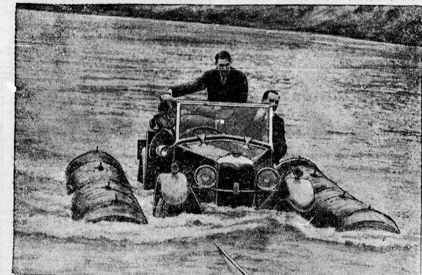
Forscher Malins angol mérnök az uszó gépkocsit megkonstruálta. A tíz levegővel telített ballonnal felszerelt jármű a vizen éppoly könnyen közlekedik, mint az országúton.
