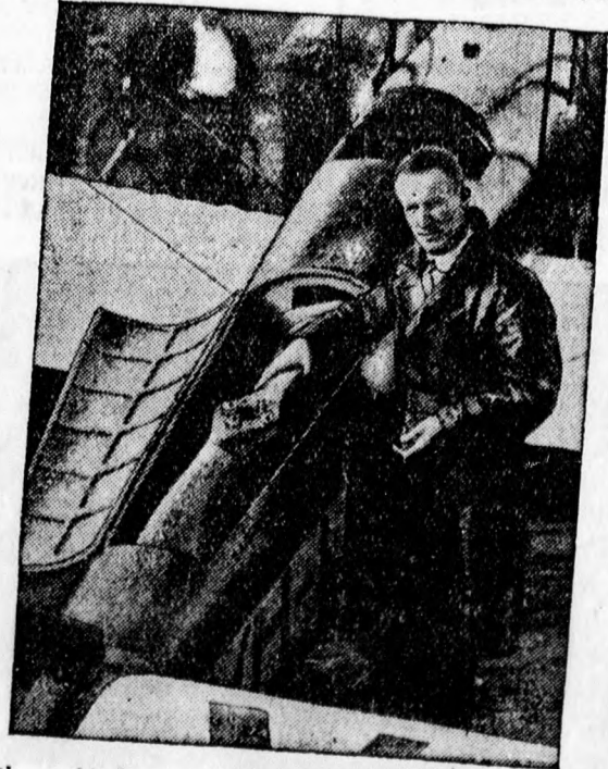
Kingsford Smith, a híres ausztráliai repülő gépének törzsébe tartalék légcavart épített be, amit ő maga könnyen fel tud szerelni.
