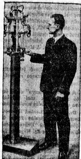
A világ legnagyobb rádióadója, 1 méter 70 centiméter magas, a berlini rövidhullámú állomáson van. 300 kilowatt teljesítménye van, ami lőerőre átszámítva 400 lőerőt jelent. Eddig a legerősebb adóállomás 170 kilowatt teljesítményű volt.
