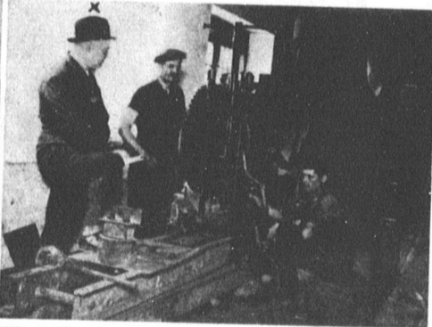
A Dorn Gépgyár üzeméből. Görbített cséplőtengelyek préselése és esztergályozása. x jelezve Dorn István mérnök, a gyár vezetője. (Francziszky Gy. felvételei.)
