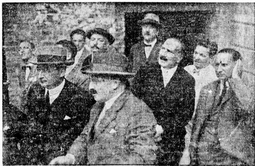
A központi épületnél működő betonöntő gépet tekinti meg a kultuszminiszter.
