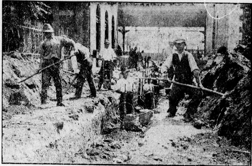
Vizvezeték-csatornázási munkálatok a Nagyállomáson.
