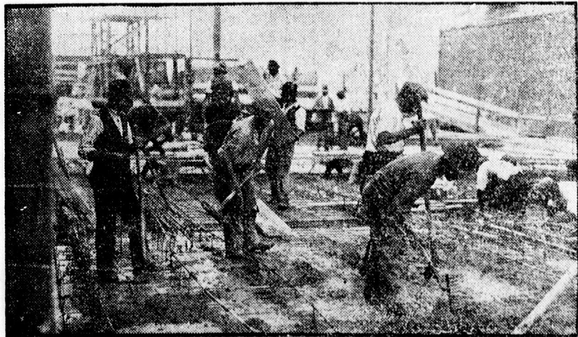
Serényen folyik a munka a Svetits-bérház építésénél.
