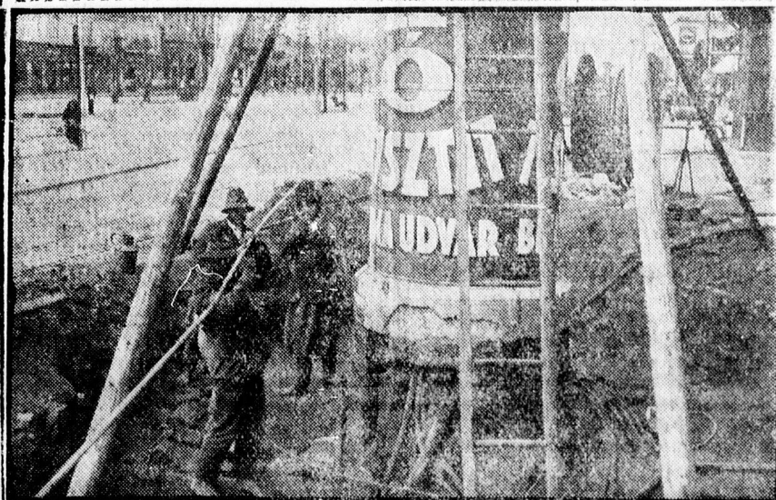
Uj villamos kábelt fektetnek le a Piac utcán.
