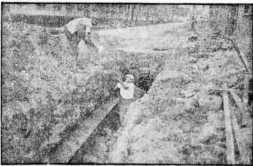
A Honvéd-utca burkolásáról. — Régi csatorna elbontása.
