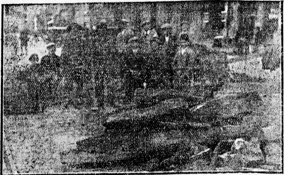
Régi palló-maradványokat találtak a postapalota kábellefektetési munkálatai nál a Piac-utcán.
