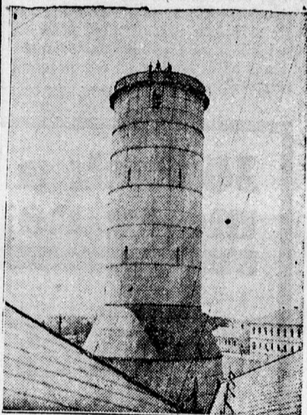
A rekkenő hőségben 37 méter magasságban, csak egy kötél által tartott kosárban javítják a gázgyár hűtőjét Siposs Kálmán és három társa.
