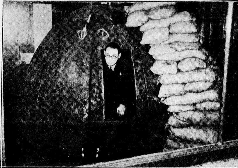
Hordozható légvédelmi óvóhely acélból. Angliában gyártanak ilyen óvóhelyeket, melyeket egyik helyről a másikra könnyen lehet szállítani.
