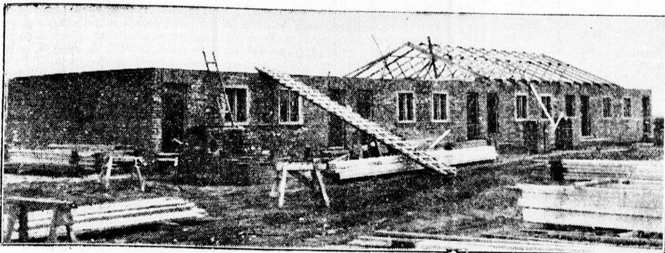
Az épülő szükséglakások a Kishegyesi úton.
