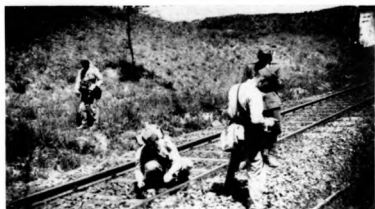
Távbeszélő vonal építése.
