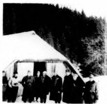
Az „Apsnyjec” vízfogóánl.
