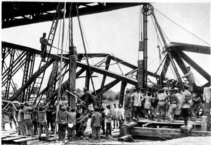
Österreichisch-ungarische und deutsche Eisenbahntuppen bei der Wiederherstellung einer zerstörten Brücke. — Osztrák-magyar és német vasutasapatok egy elpusztított hidat állítanak helyre. — Troupes de chemin de fer austro-hongroises reconstruisant un pont détruit. — Trupe de cale ferată austro-ungare și germane reconstruind un pod dărâmat. — Austro-Hungarian and German engineers rebuilding a bridge. — Austro-ugarske i njemačke željezničke čete uspostavljaju jedan razoreni most.
