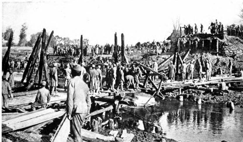
Wiederherstellung einer von den Russen verbrannten Brücke durch Infanteriepioniere. — Gyalogsági hidászok helyreállítanak egy az oroszoktól felégetett hidat. — Pioniri uspostavljaju most, što su ga Rusi spalili. — Reconstruirea unui pod ars de Ruși prin pioniri de infanterie. — Pionniers de l'infanterie reconstruisent un pont incendié par les Russes. — Infantry pioneers reconstruct a bridge set on fire by the Russians.
