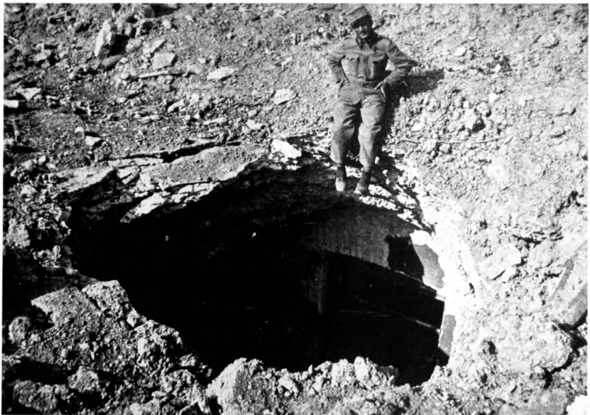
Volltreffer einer 30·5 cm-Granate in die Betondecke eines Forts. — Harmine és feles gránátunk így találta telibe az egyik erőd betonfedelét. — Zgoditak granate od 30·5 cm u betonskom oklopu. — 30·5 centimetrový granát zasáhl plně betonový strop tvrže. — Celny strzal 30·5 cm granata w betonowe pokrycie fortu. — O împuşcătură bine nimerită a unei granate de 30·5 cm în acoperişul de beton al unui fort. — Effet d'un obus de 30·5 cm dans la couverture bétonnée d'un fort. — A good hit of a 30·5 cm shell in the beton cover of a fort.
