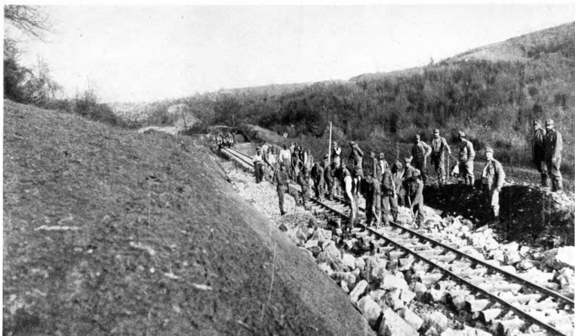
Legen des Oberbaues einer Feldbahn. — Tábori vasút felépítményének készítése. — Izgradnja pruge poljske željeznice. — Práce při vrchní stavbě polní dráhy. — Budowa kolei polowej. — Clădirea unei căi ferate de câmp. — La mise de la superstructure d'un chemin de fer de campagne. — Building of the superstructure of a field-railway.
