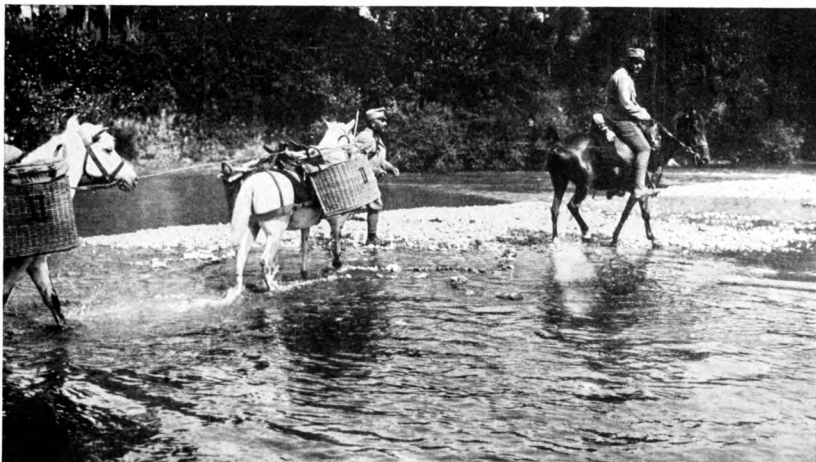
Legung eines Telephonkabels im Flußbett. — Tárhészelővezeték lefektetése a folyómederbe. — Polaganje telefons kog kabela kroz rijeku. — Kladeňí telefonního kabelu v řečišti. — Zakładanie kablu telefonicznego w korycie rzeki. — Așezarea unui cablu telefonic în albia unui râu. — On met un cable téléphonique dans le lit d'une rivière. — Placing of a telephone-cable in a river-bed.
