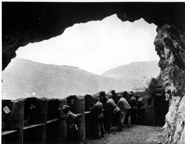
In den Fels gesprengter Schützenstand. — A sziklába robbantással vájt fedezék. — Strijeljačka postava, načinjena u pećini. — Ve skále zbudované střelecké postavení. — W skále wysadzonej pozycyi strzeleckiej. — Un tranșeu clădit într'o spărtură de stâncă. — Tranchée construite dans une roche sautée. — Shelters made by explosions in the rocks.
