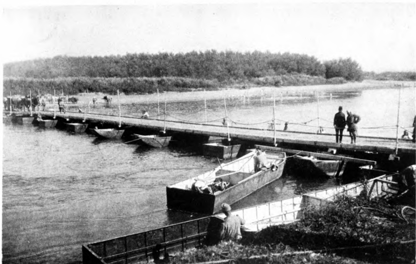
Kriegsbrücke über die Drina. — Hadi hid a Drinán. — Ratni most preko Drine. — Válečný most přes Drinu. — Wojenny most na Drinie. — Wojennyj mist na Drynjl. — Pod militar peste Drina. — Pont militaire sur la Drina. — A military bridge on the Drina.
