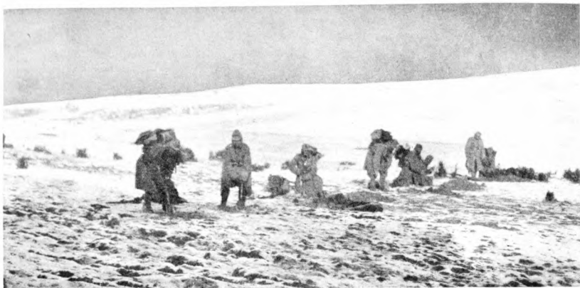
Die ersten Spatenstiche zum Schützengraben. — A lövészárok első ásóesapásai. — Prvi ubodi lopatom za strijeljački jarak. — První práce lopatom při hloubení střeleckého zákopu. — Pierwsze uderzenia łopaty przy budowie rowu strzeleckiego. — Perszi udary ryskala pry budowi zakopiw. — Cele diații săpături pentru a se face un tranșeu. — Les premiers coups de bêche, pour une tranchée. — Beginning of spading for a trench.
