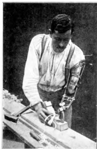
Arbeitsprothese (Eichmann) mit auswechselbaren Anhängen
