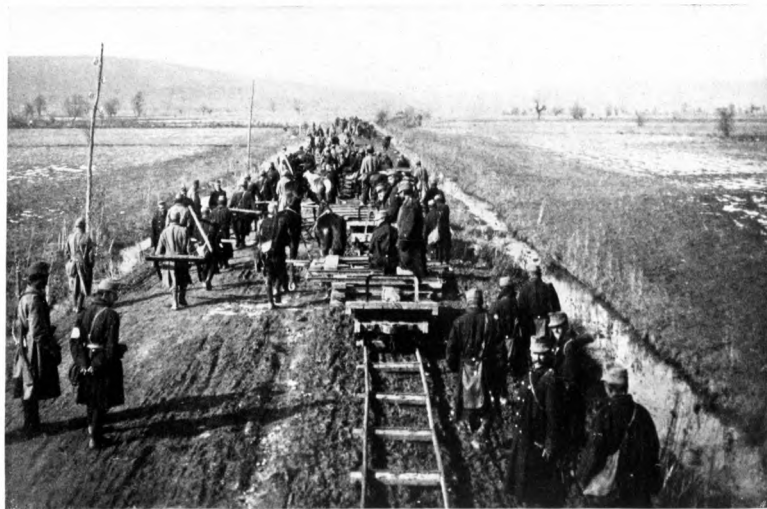
Feldbahnvorbau in Albanien. — Tábortí vasút építése Albániában. — Izgradnja poljske željeznice u Albaniji. — Přípravy ke stavění polní dráhy v Albánii. — Budowa kolei polowej w Albanii. — Budowa polowej koliji w Albanii. — Clădire de linie ferată în Albania. — Les traces d'un chemin de fer en Albanie. — Construction of a field-railway in Albania.
