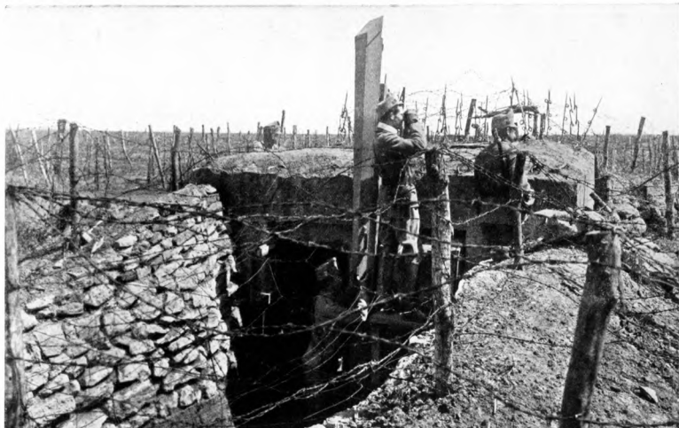
Betonierte österreichisch-ungarische Maschinengewehrstellung. — Betonnal megerősített osztrák-magyar gépfegyverállás. — Betonirani položaj austro-ugarskih pušanih strojeva. — Betonované rak.-uhers. postavení strojní pušky. — Betonovaná austr.-weg. pozycja karabinów maszynowych. — Betonowane stanowyszcze awstr.-uh. maszynowych krsiw. — Postije de mitraliere betonată austro-ungară. — Postillon de mitrailleuses betonées austro hongroise. — Beton-position of Austro-Hungarian machine-guns.
