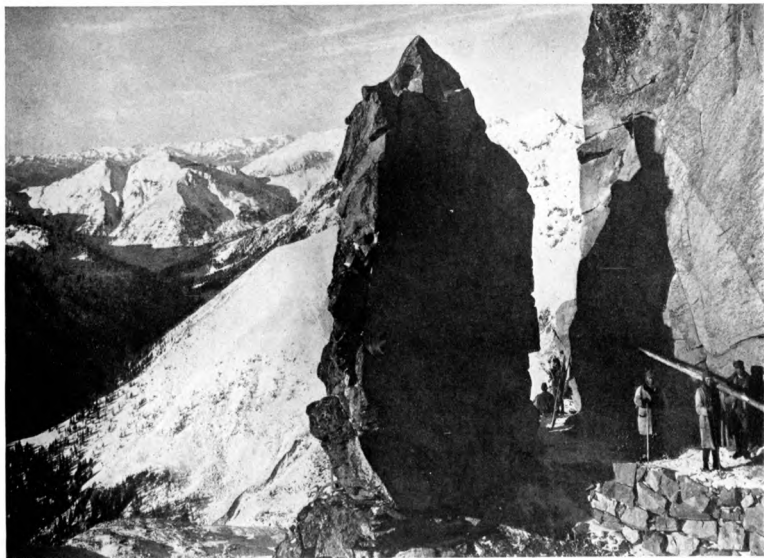
Wegbau in den Alpen. — Útépítés az Alpeseekben. — Izgradnja cesta u Alpama. — Stavba cest v Alpach. — Budowa drogi w Alpach. — Budowa drohy w Alpach. — Construcție de drumuri în Alpi. — Construction d'une chaussée, dans les Alpes. — Road-making in the Alps.
