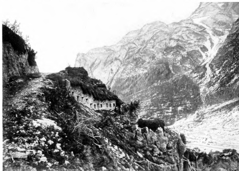
Österreichisch-ungarische betonerte Infanteriestellung in den Alpen. — Osztrák-magyar betonozott gyalogsági állás az Alpesebben. — Austro-ungariskí betonirani gješadijski položaj u Alpama. — Betonované postavení rakous.-uhers. pěchoty v Alpách. — Betonowane stanowisko austr.-weg. piechoty w Alpach. — Betonowane stanowyszece austro-uhorskoj piechoty w Alpach. — Pozicje de infanterie austro-ungarâ betonatâ, în Alpi. — Position d'infanterie austro-hongroise bétonée, dans les Alpes. — Austro-Hungarian infantry-position in the Alps.
