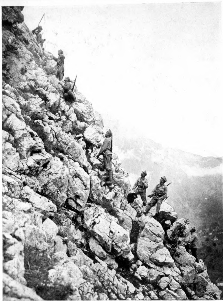
österreichisch-ungarische Feldtelegraphenabteilung beim Kabelbau im Krngebiet. — Osztrák-magyar tábortívesztés osztag kábelépítés közben a Krn vidéken. — Austro-ung. odlo za bojno hrvojavljene kod gradeže kabela u područja Krna. — Rak.-uhers. polni telegrafni oddeleni pri kladení kabelového lana v okolí Krna. — Austr.-weg. oddzial telegrafistow polowych przy budowie kablu na obszarze Krn. — Awstr.-uh. wíddíl polowych telegrafistw przy zakładaniu telegrafu w okolicy Krna. — Detasament de telegraf de camp austro-ungar, construínd un cablu in regiunea lui Krn. — Detachement de télégraphe de camp austro-hongrois construisant un cable dans le Krn. — Austro-Hungarian telephone-section constructing cables in the Krn-district.
