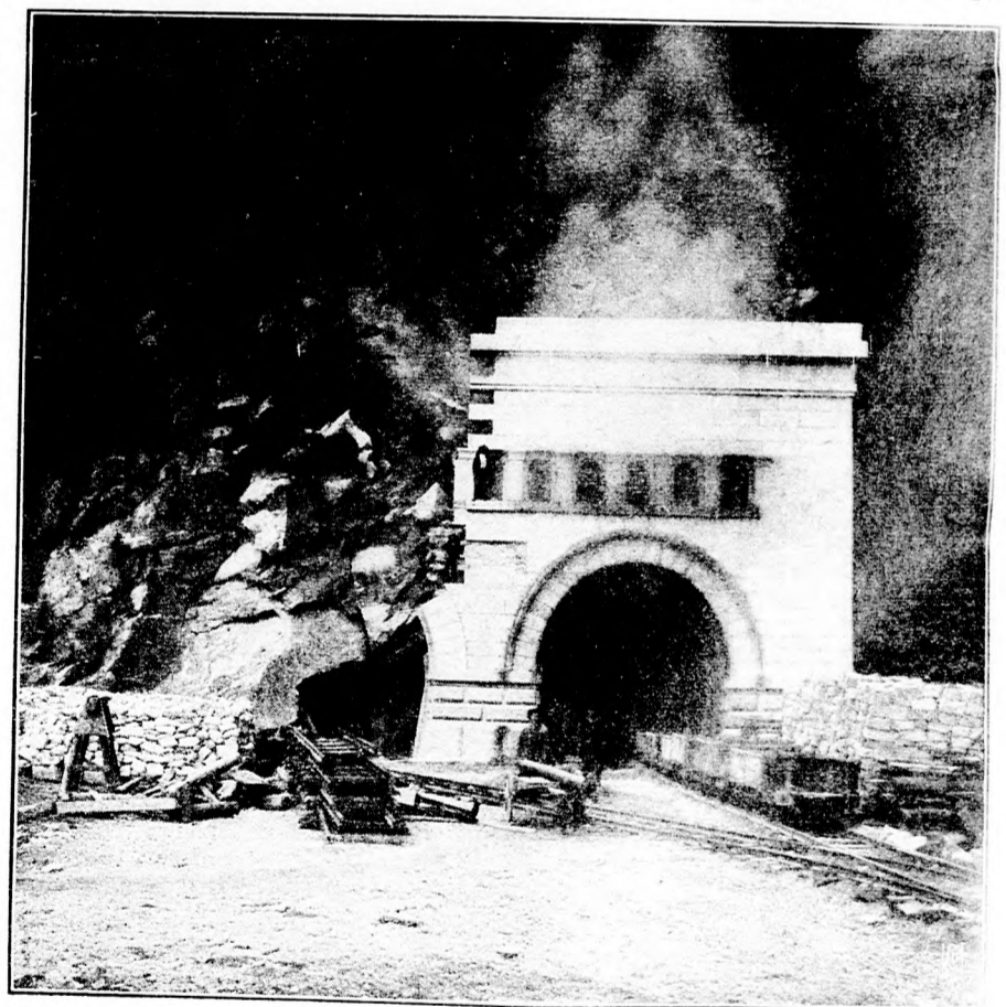
Südportal des großen Simpfontunnels bei Nelle mit der Simpfonstraße im Vordergrund. Photographien von A. Braun. (Mit Text.)
