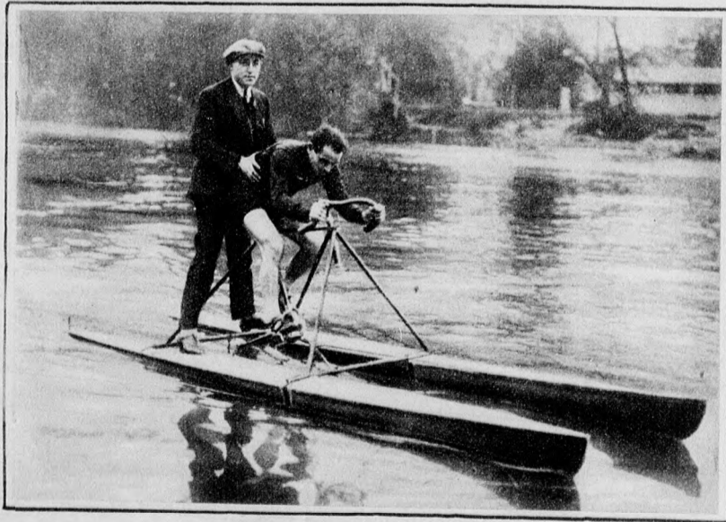
Savard, a híres francia bűvár a La Manche-csatornát akarja saját találmányú „vízibicikli“-jével átszeli és erre az útjára treniroz Liegeois, a híres francia automobilista társaságában. A két összeszerelt csónaktest közé mélyenfekvő propellert állított be, amelyet meglehetősen nagy áttétellel, a lábával hajt. Ha csendes lesz a csatorna, valószínűen sikerül a kísérlet, de ha csak közepes hullámok lesznek, akkor igen könnyen felborulhat
