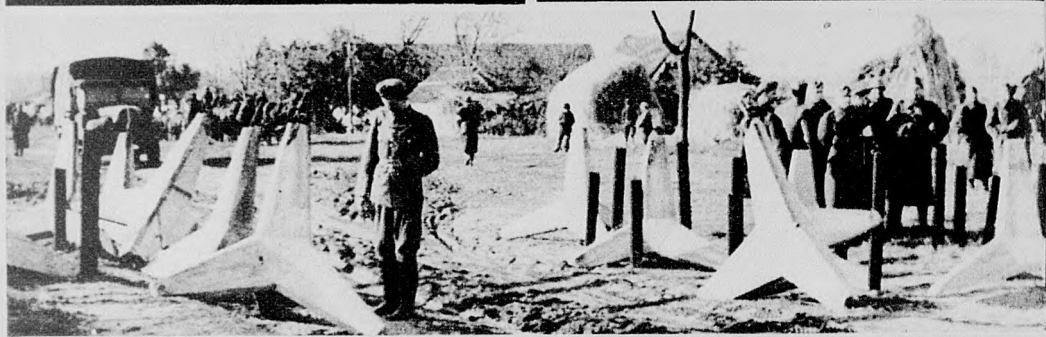
Ártalmatlanná tett útzáró csillagok
