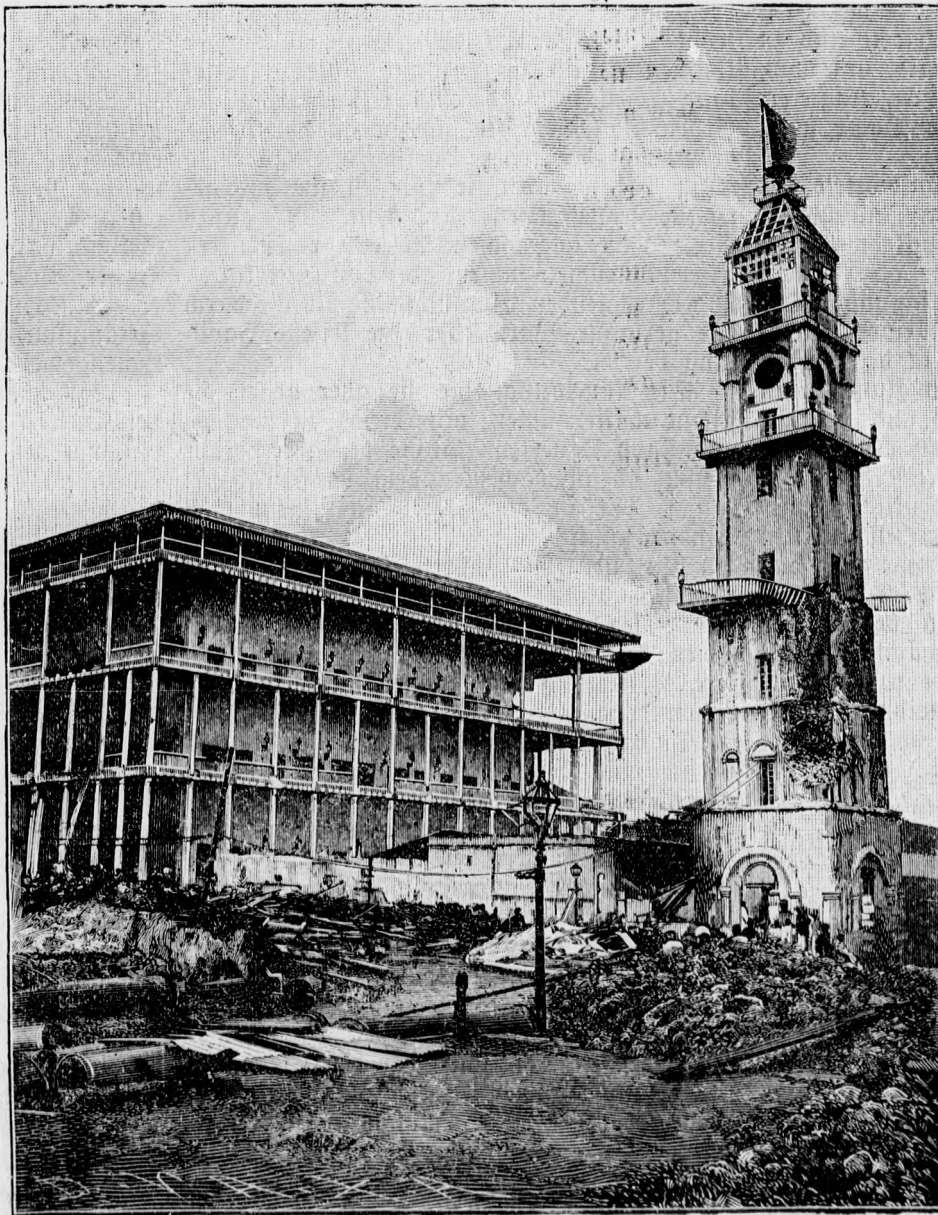
der geplanten Leuchtturm und Seitenflügel des Sultanspalastes von Sansibar nach der Beschädigung.
