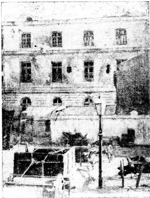
A port-arturi kórház képe az ostrom után.
