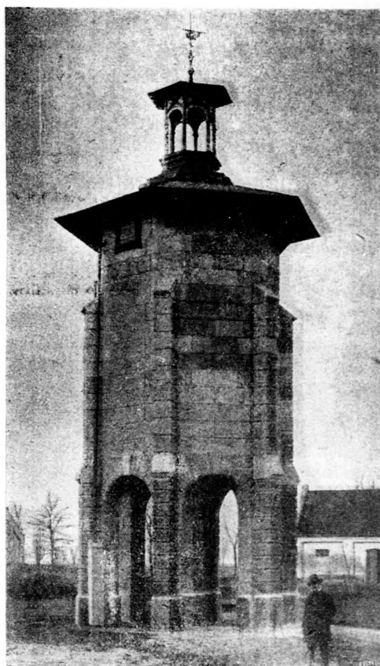
Betonvíztorony az aicsuthi főhercegi uradalomban.
