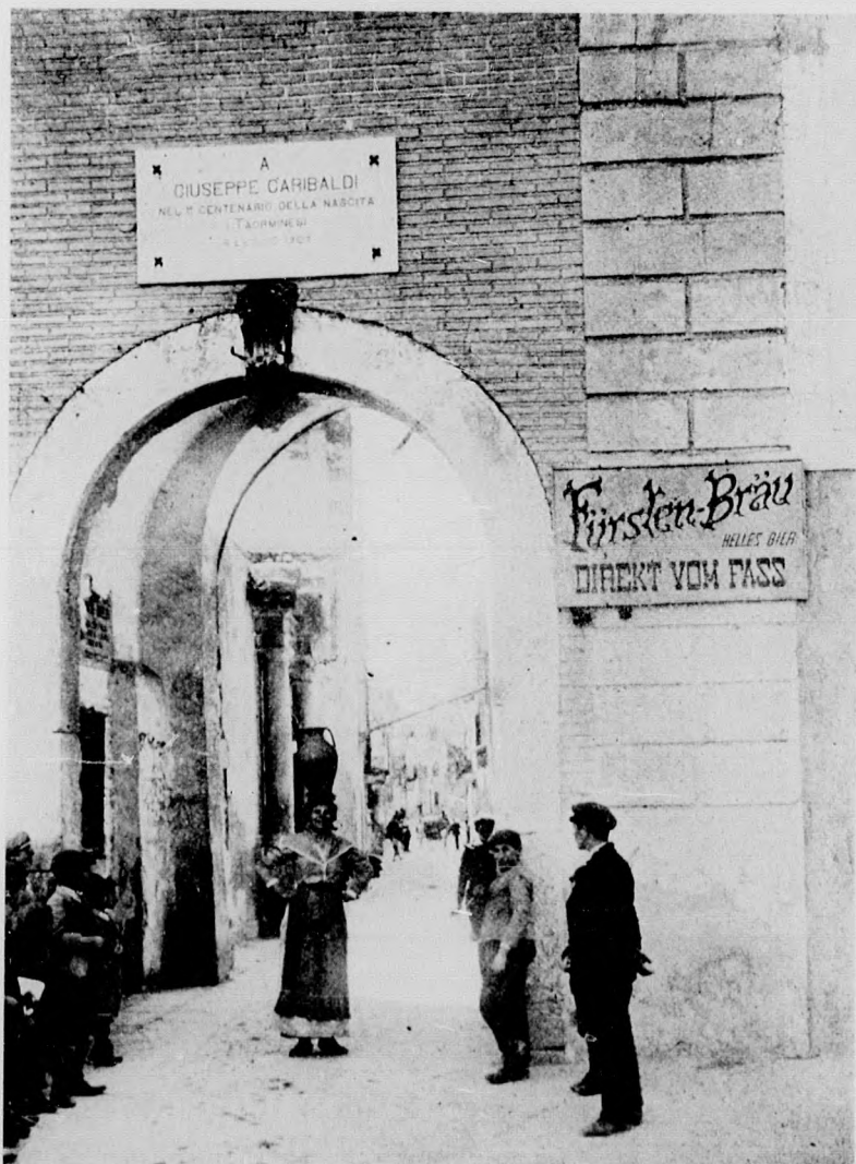
A Garibaldi-ház Taorminában. Az épület a földrengés következtében rombadőlt.
