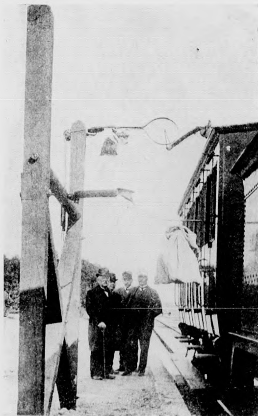
Pneumatikus csomagszállítás a vonat robogása közben. Képünk egy új találmányt mutat, amelynek segítségével lehetővé tételük, hogy a száguldó gyorsvonatokra a kis állomásokról is elhelyezzenek csomagokat anélkül, hogy a vonatnak megállnia kellene.
