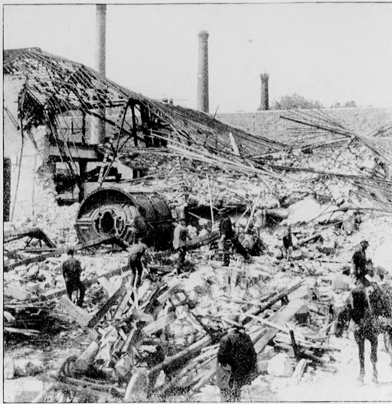
A genfi robbanás. Képünk az elpusztult gáztisztító kamrákat mutatja, középen a Standard-mosó- val, ahol a robbanás történt.
