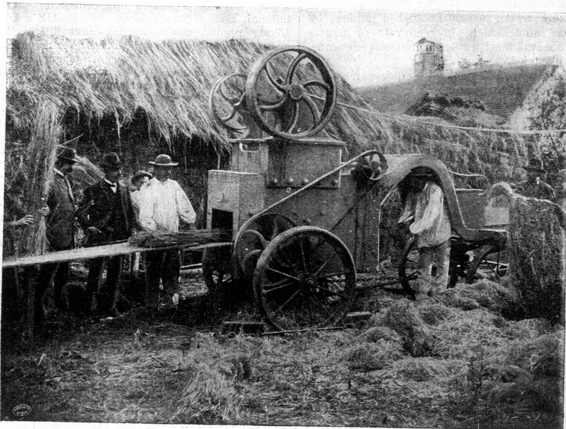
18. ábra Szendy-Müller-féle kender-törő-gép munkában.
