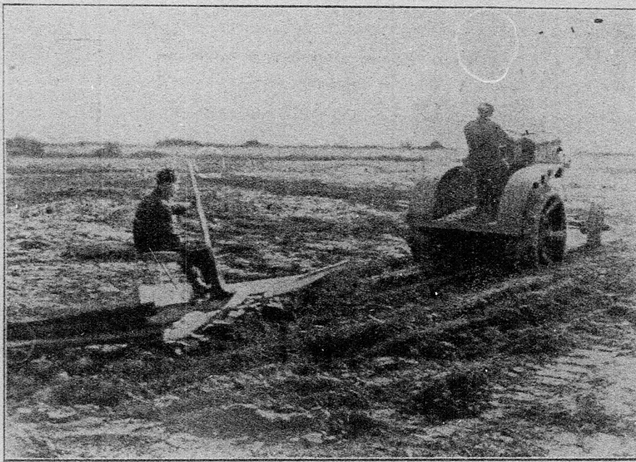
107. sz. kép. Kund-féle sáncoló gép munkaközben.
