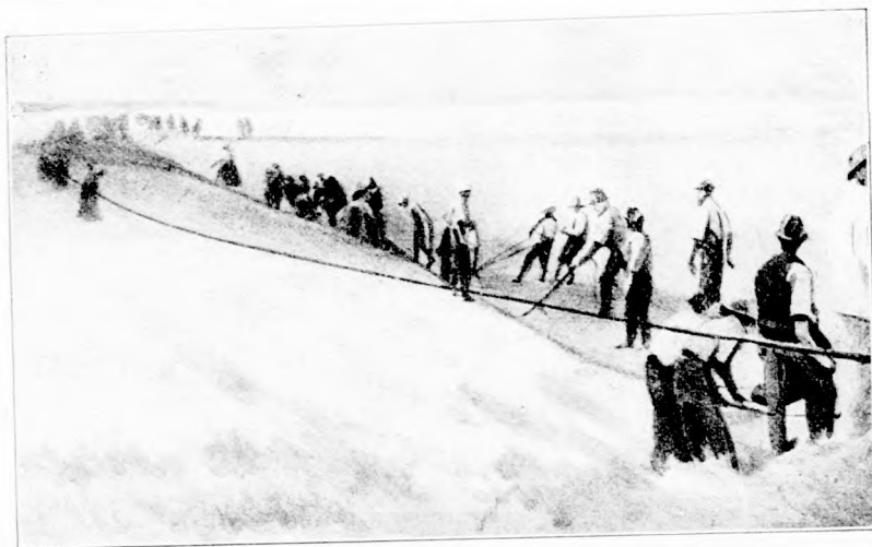
A FÖLDKÖRÜLI TÁVIRÓ VEZETÉKÉNEK LERAKÁSA.
