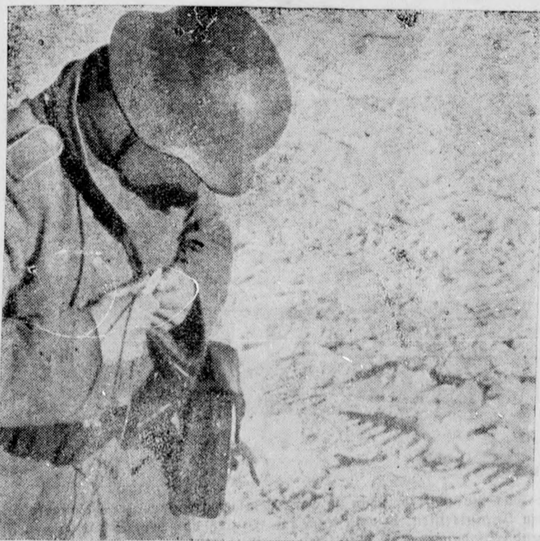
Störungsjücher bei der Arbeit. Die Leitung ist durch Artilleriebeschüß schwer beschädigt worden. Nach stundenlangem mühevollen Suchen ist die Schadenstelle gefunden worden. Nun kann das Ausbesserungswerk beginnen. (PA. Klinkisch.)
