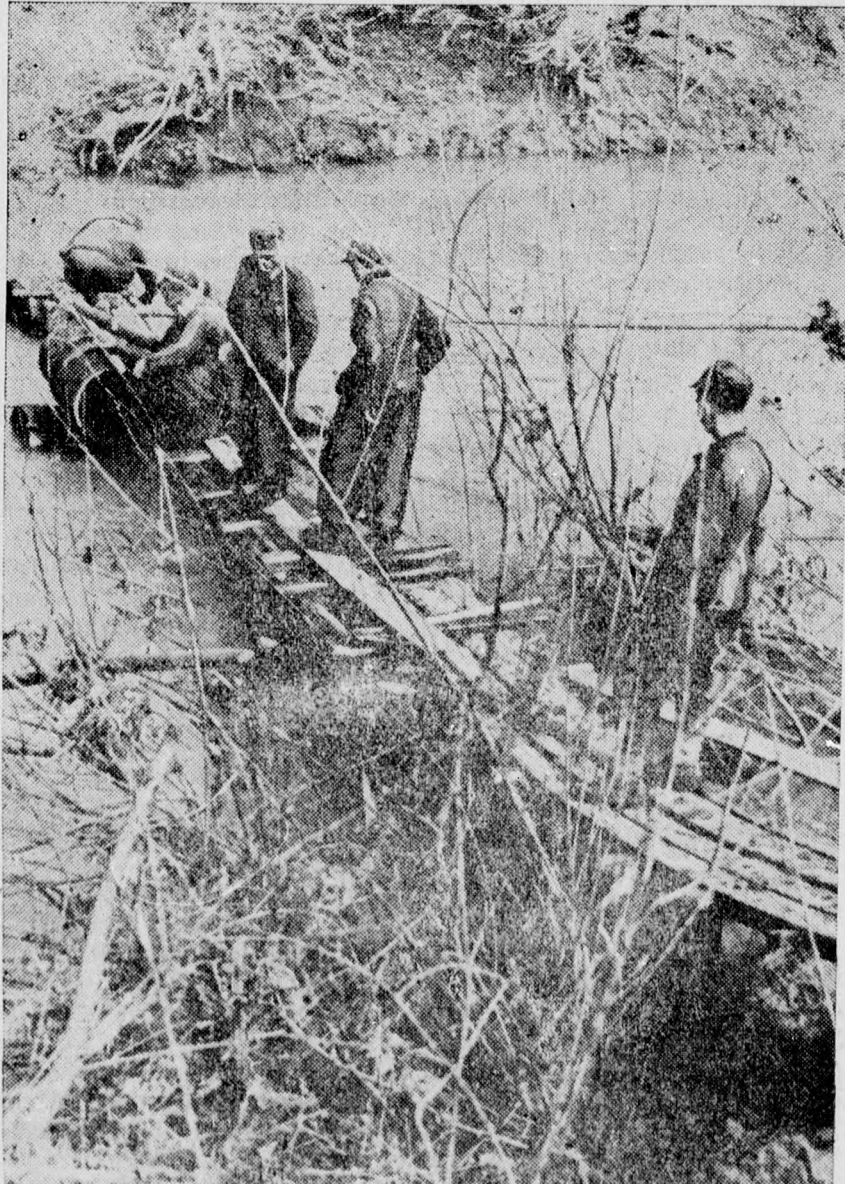
Pioniere bauen einen Ponton-Schwimmweg beim Kubantopf, damit Spähtruppen und vor allem Gefechtsposten das Niemandland besser und schneller erreichen können. (PA Kintcher)
