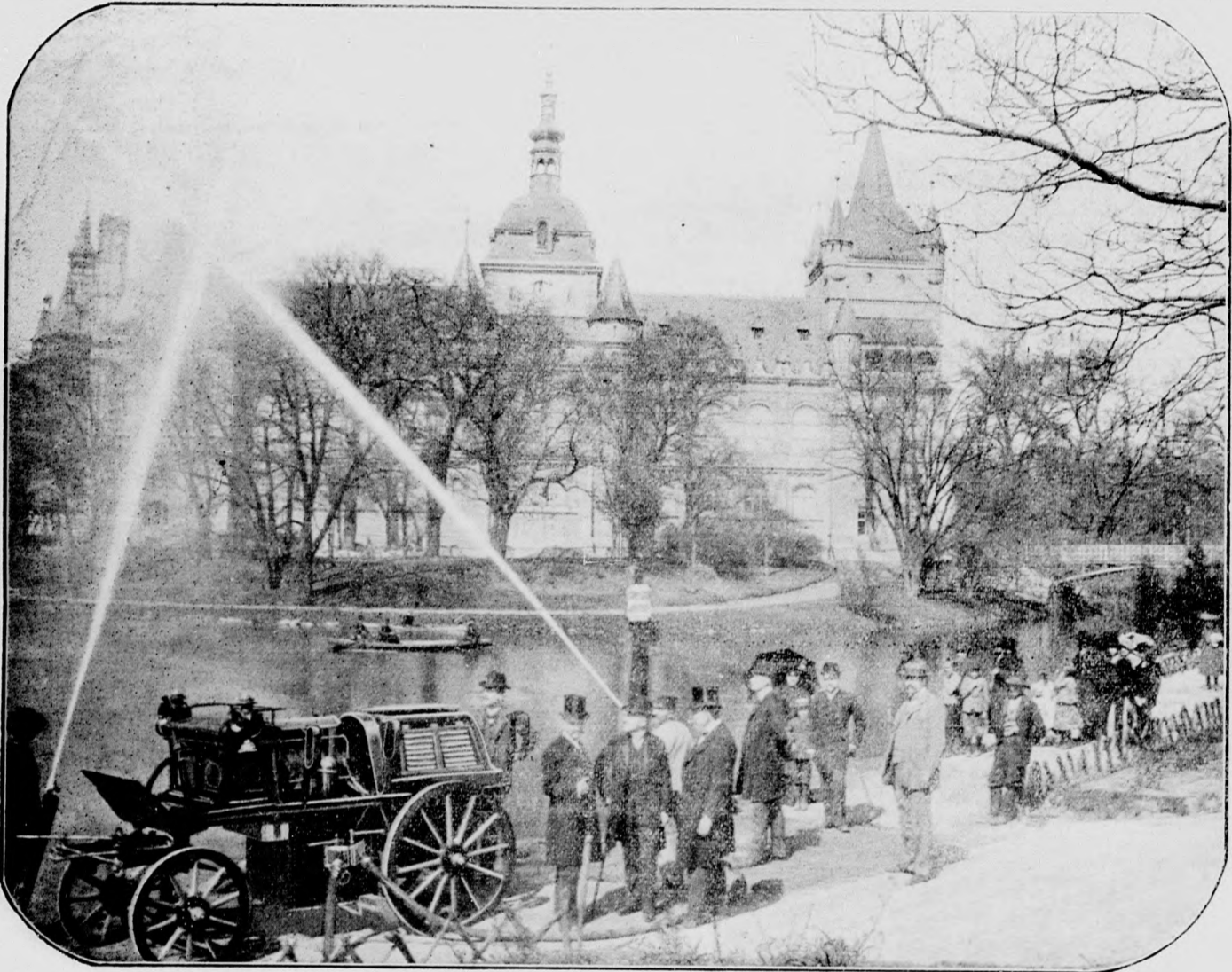
Képünk azon jelenetet ábrázolja, midőn Kovács Miksa a budapesti szivattyú és gépgyár r.-t. igazgatója a meghívott szakférfiak előtt a III. nemzetközi automobil kiállítás keretében bemutatja a motorfecskendő működését.
