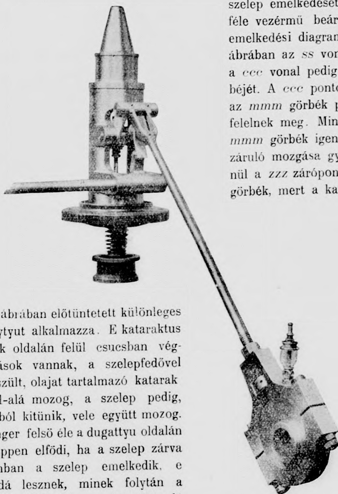
8. ábra. A beárasztó szelepnek és külső vezérműnek képe.
